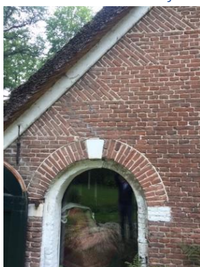
Boerderij Details: ontlastingsbogen en vlechtwerk (PMG)
